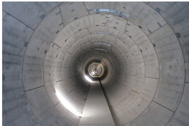
工事名：20号調布（2）共同溝他工事 発注者：国土交通省関東地方整備局
