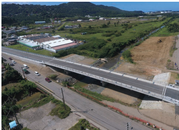
工事名：セントルシア カルデサック流域橋梁架け替え計画 発注者：セントルシア国インフラ・港湾・エネルギー・労働省
