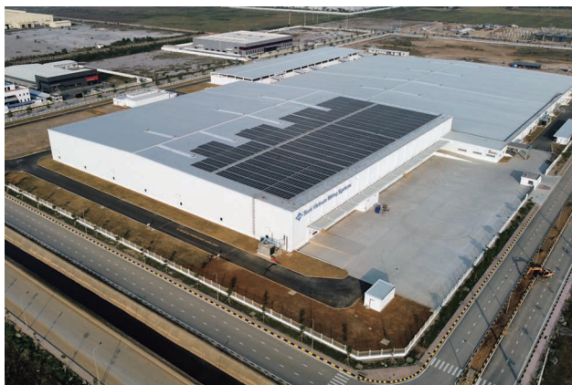
工事名：住友電装（SVWS）ベトナム第3工場建設工事 発注者：Sumi Vietnam Wiring Systems Co., Ltd.
