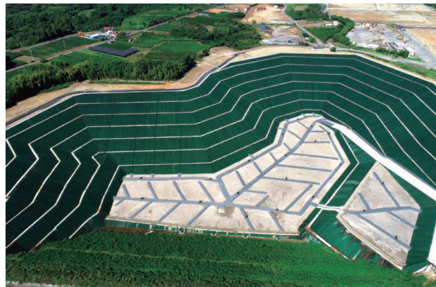
工事名：新小山最終処分場増設事業本体工事 発注者：一般財団法人三重県環境保全事業団
