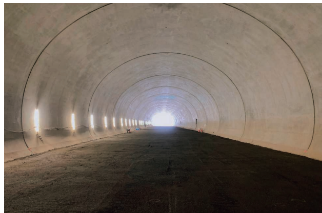
工事名：R 1 - 4 朝日温海道路4号トンネル工事 発注者：国土交通省北陸地方整備局
