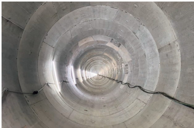
工事名：R 3 霞ヶ浦導水石岡トンネル（第1工区）新設工事 発注者：国土交通省関東地方整備局
