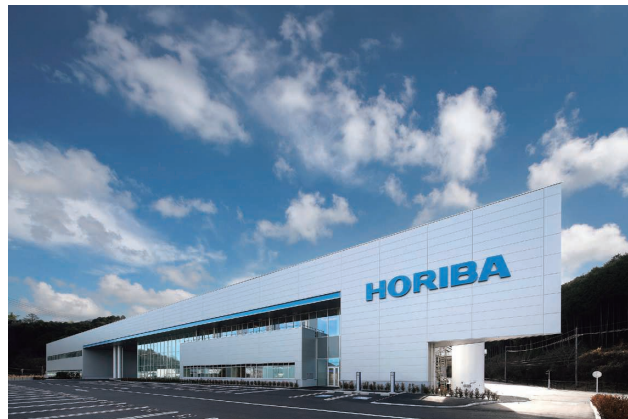
工事名：堀場エステック 京都福知山工場建設工事 発注者：株式会社堀場エステック
