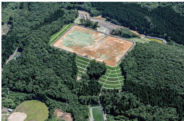
工事名：河辺(変)新設工事のうち土木第一期工事 発注者：東北電力ネットワーク株式会社
