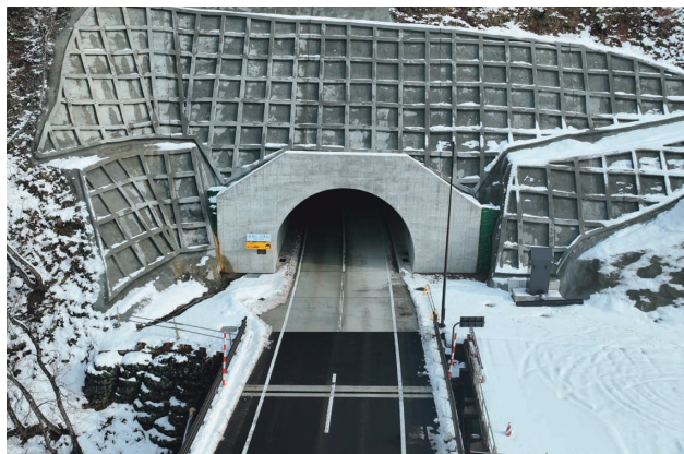
工事名：一般国道107号大石地区道路災害復旧(トンネル築造)工事 発注者：岩手県
