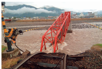
崩落した橋台と傾いた橋脚
