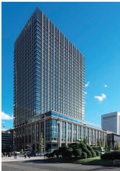
◀ 丸の内二重橋ビル 新築工事 (東京都千代田区) 発注者: 三菱地所株式会社・東京商工会議所・株式会社東京會館
