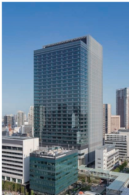
◀ (仮称) TGMM芝浦プロジェクト(A棟・ホテル棟新築工事) (東京都港区) 発注者: 三井不動産株式会社・三菱地所株式会社
