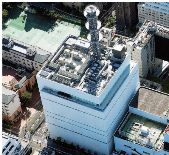
▲ (仮称) 麹町新スタジオ棟建設プロジェクト (東京都千代田区) 発注者: 日本テレビ放送網株式会社
