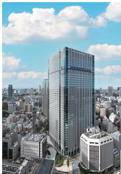
(仮称)赤坂二丁目プロジェクト 新築工事 (東京都港区) 発注者:森トラスト株式会社 NTT都市開発株式会社
