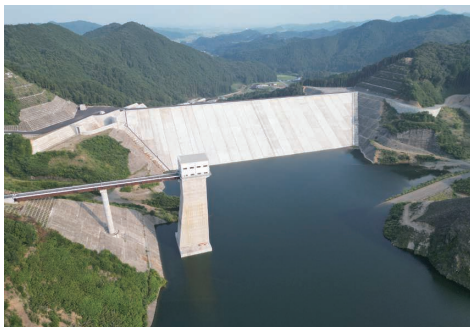
南摩ダム本体建設工事 (栃木県鹿沼市) 発注者:独立行政法人水資源機構
