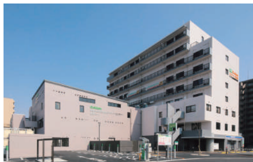
学研廿日市市多世代サポートセンター・学研ホール (公共施設棟)、ココファン廿日市(民間施設棟) 広島県 発注者：株式会社学研ココファンホールディングス
