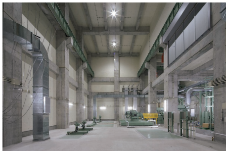
<上写真> 石巻市石巻港排水ポンプ場他2施設復興建設工事その2 宮城県 発注者：地方共同法人日本下水道事業団
