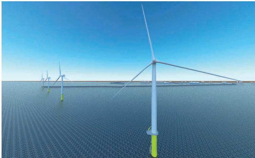
秋田港に建設される洋上風車（イメージ）
