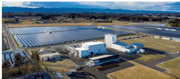
福島水素エネルギー研究フィールド (FH2R) 全景
