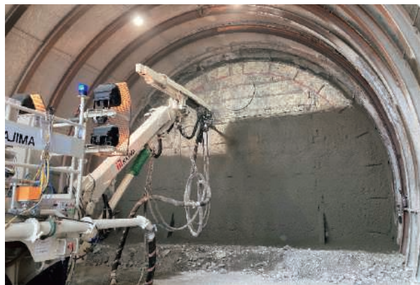
自動吹付機による切羽面の吹付けの様子
