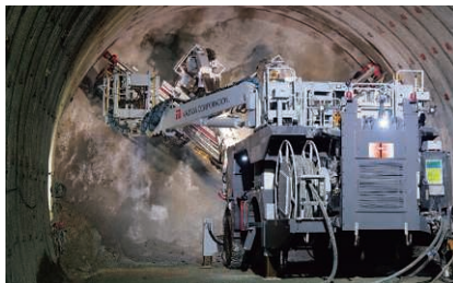
2ブームロックボルト施工機
