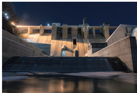
沙流川総合開発事業の内平取ダム堤体建設工事
