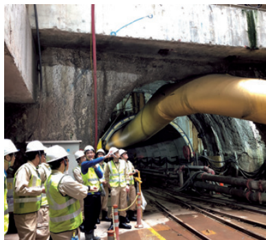
海外現場研修 （シンガポール 大深度下水幹線トンネル T10工区工事）
