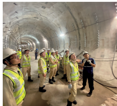
海外現場研修 （シンガポール 地下鉄サークルラインケッ ペル駅及びトンネル工事）
