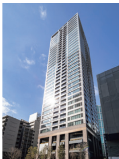
(仮称)高輪一丁目共同建替計画マンション建替工事
