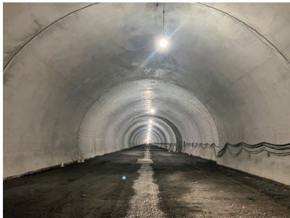
令和2－5年度 窪川佐賀道路不破原トンネル工事
