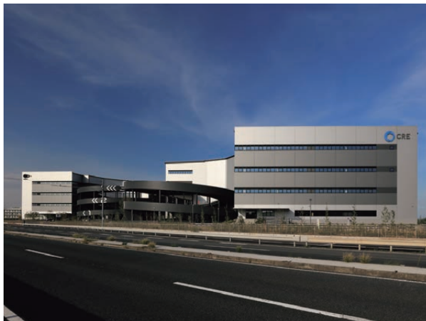
ロジスクエアふじみ野A・B新築工事
