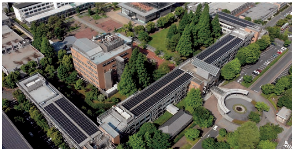
本館屋上発電所
