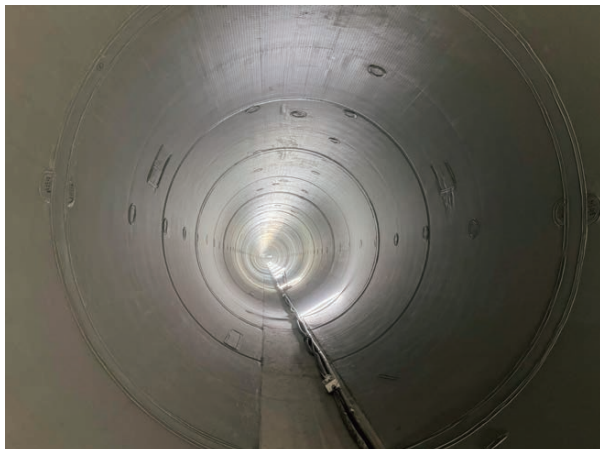
大深度下水幹線トンネルT10工区工事
