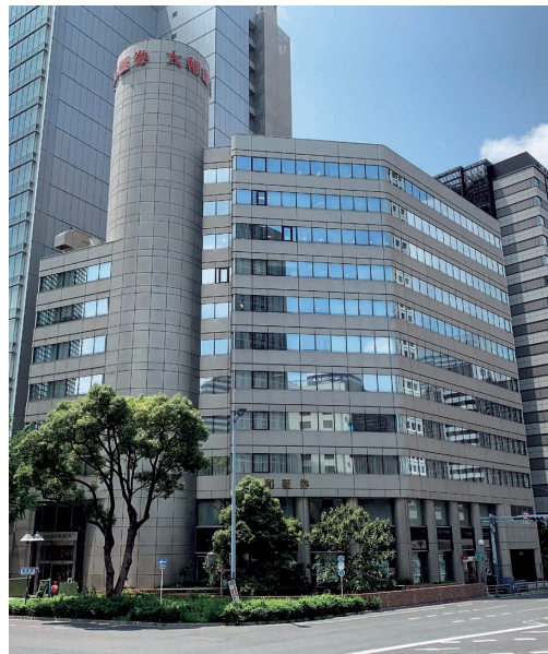
大和証券大阪支店ビル（大阪市北区）
