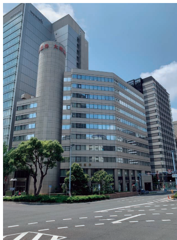
大和証券大阪支店ビル （大阪市北区）
