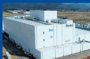
※五泉事業所鏡田工場 製造新棟の外観
