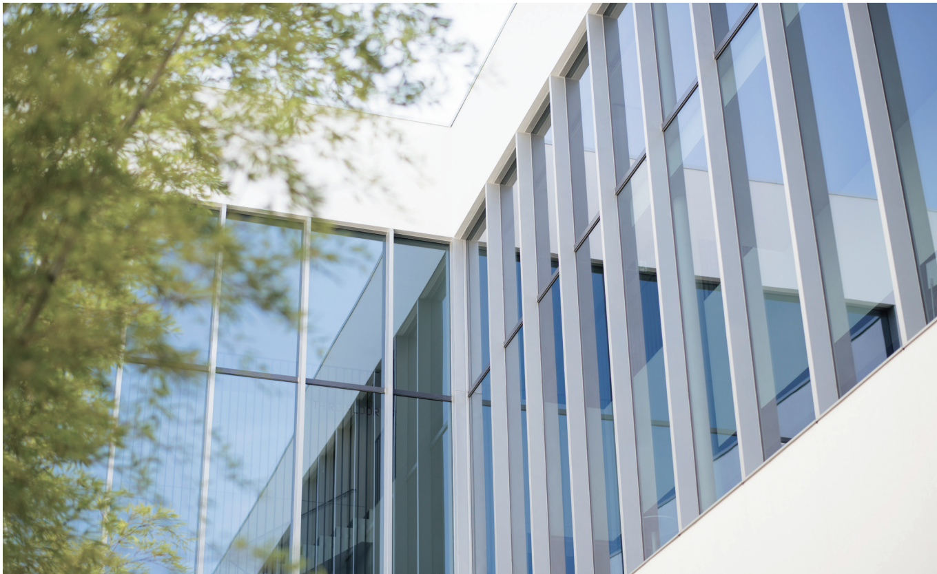
デンカイノベーションセンター／東京都町田市
