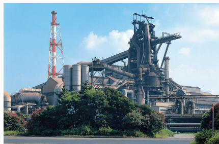
JFEスチール株式会社東日本製鉄所 (千葉地区) 第6高炉
