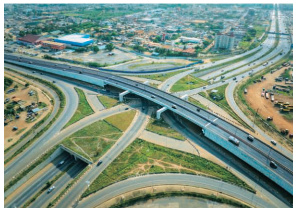
ガーナ共和国 テマ高架橋
