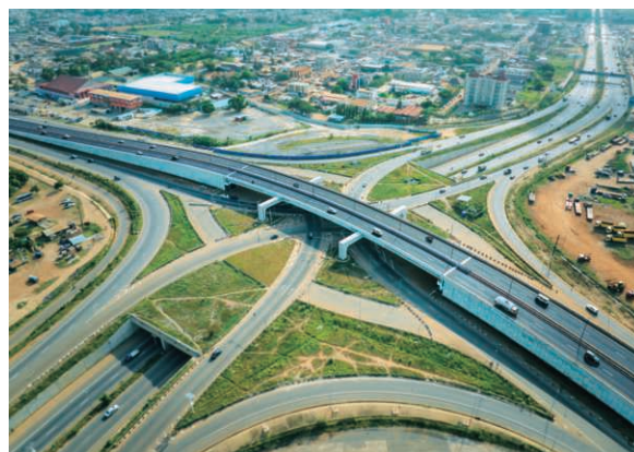
ガーナ共和国 テマ高架橋
