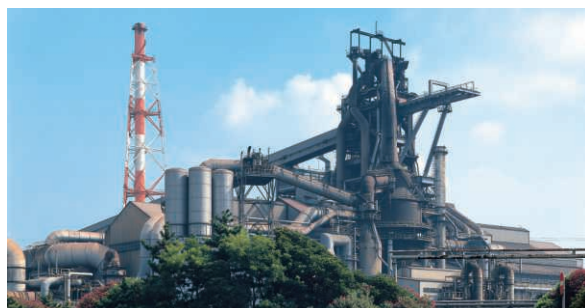
JFEスチール株式会社 東日本製鉄所（千葉地区）第6高炉
