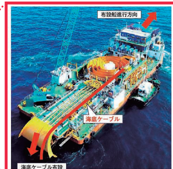
海底ケーブル布設作業
