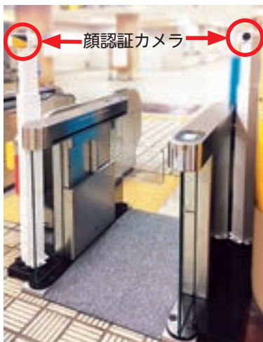
Osaka Metro 堺筋線 顔認証技術を用いた次世代改札機
