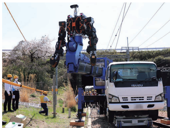
多機能鉄道重機
