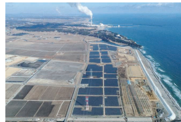
太陽光発電所(福島県南相馬市)
