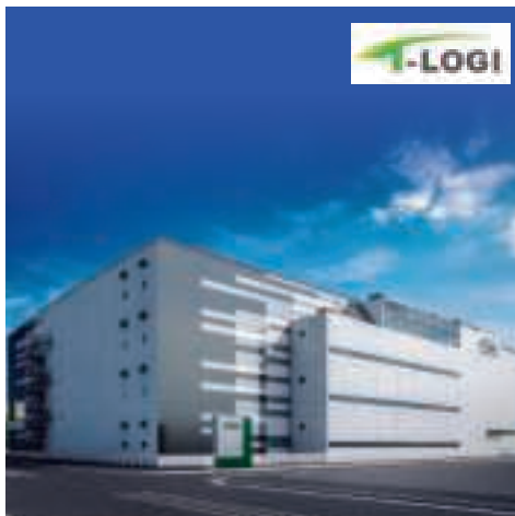
(仮称)T-LOGI(ティーロジ)習志野 ／千葉県習志野市、2022年1月竣工予定
