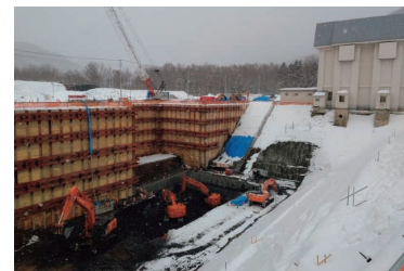
上川発電所リプレース工事の様子
